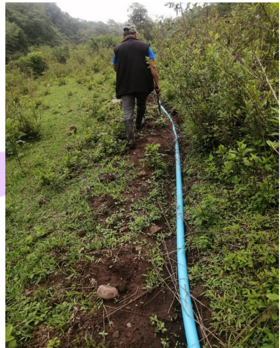
Excavado y tendido de tubería
